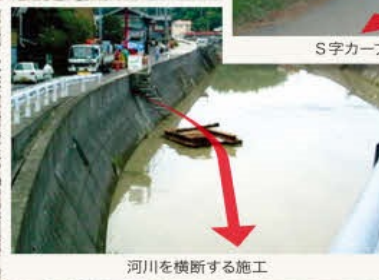
河川を横断する施工
